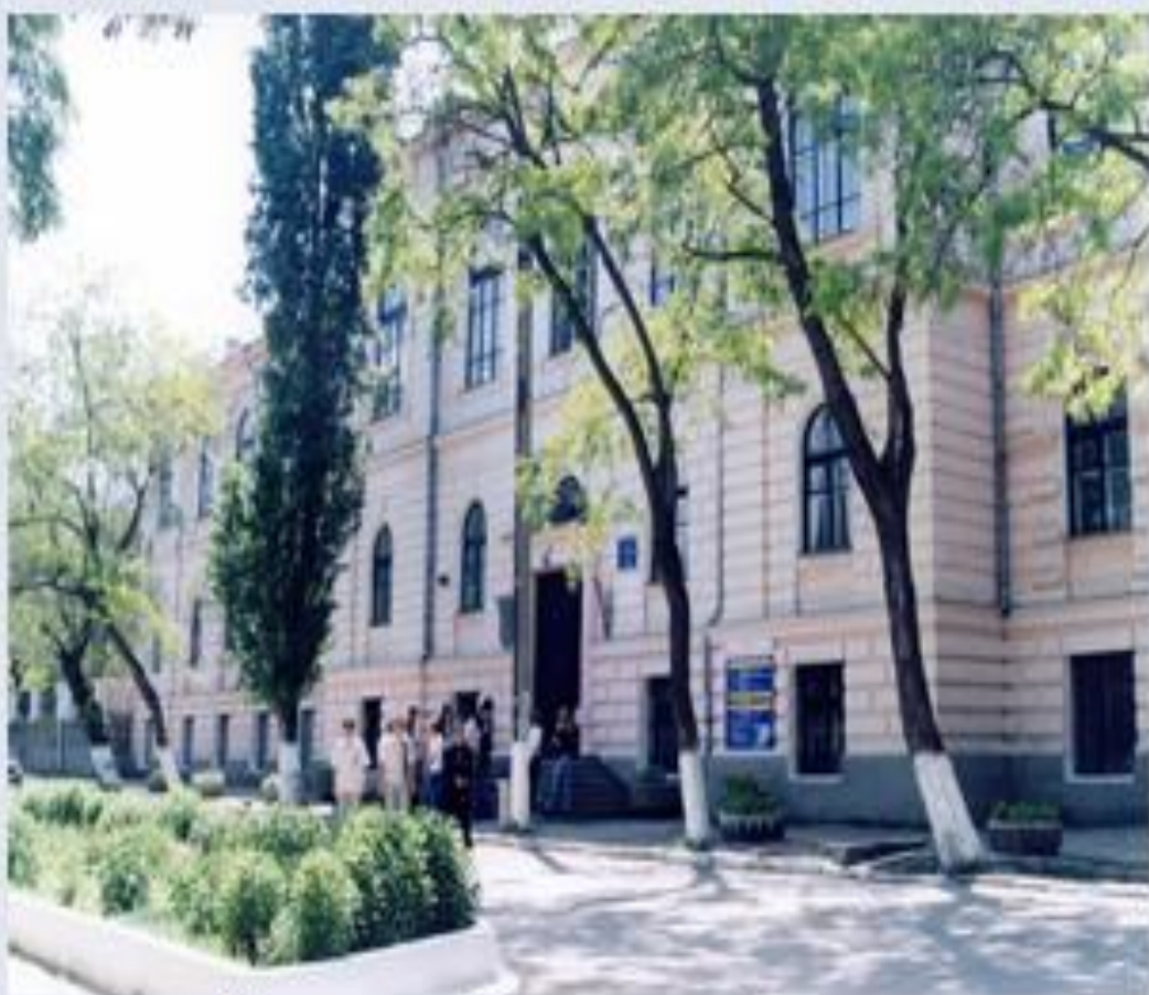
Современный вид здания Академии
